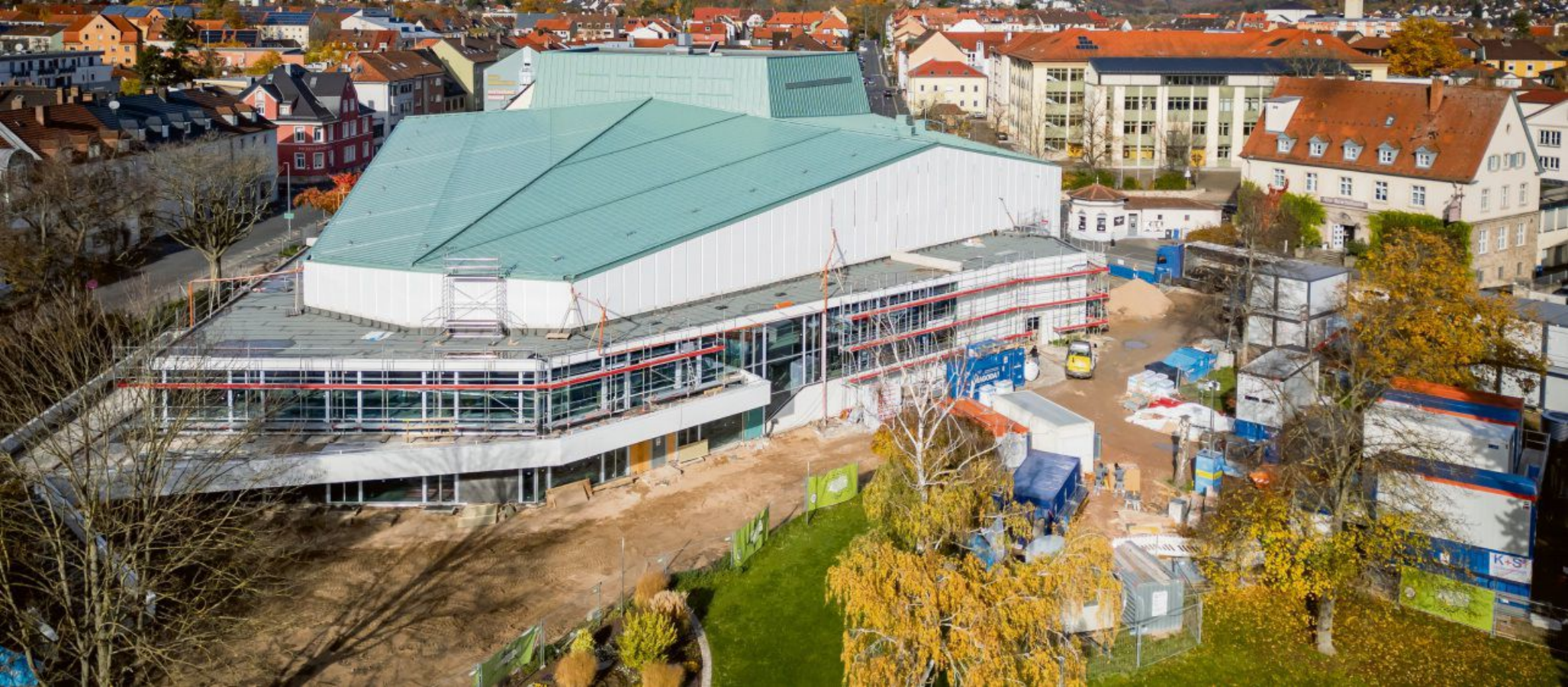
Die Baustelle des Theaters in Schweinfurt im Herbst 2025. Wann das Haus wieder eröffnet werden kann, ist noch offen. Foto: Silvia Gralla
