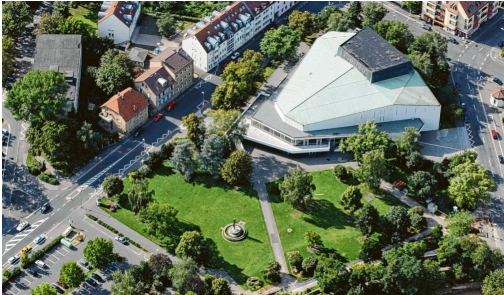
Die Sanierung des Schweinfurter Theaters mit seinem markanten Dach wird noch einmal teurer. Die Planer schätzen bis zu 70 Millionen Euro. Wiedereröffnet wird das Theater im Oktober 2027. Foto: Maximilian Stuhl
