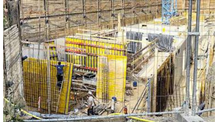
Die Baugrube für die Erweiterung mit verschiedenen Funktionsräumen im Keller schreitet schnell voran.
